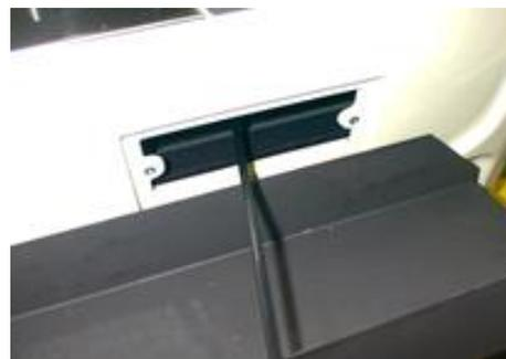
*Figura n°20 - Accessi per la pulizia dello scarico fumi.*
