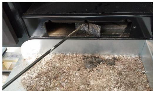
*Figura n°20 - Accessi per la pulizia dello scarico fumi.*
