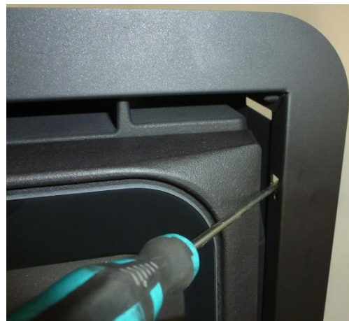
Figura n°13 - Modo di piegare le linguette
