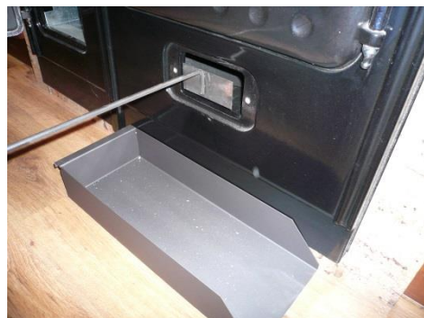
Figura n°19 - Accessi per la pulizia dello scarico fumi.
